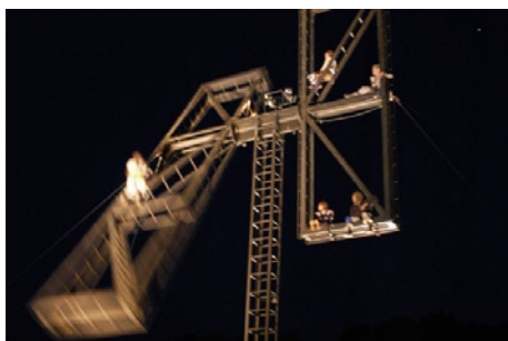
artistik - bühnen - konstruktion «luftstation» für öff-öff productions, bern stahlkonstruktion, 2 drehb. flügel, h = 17m
