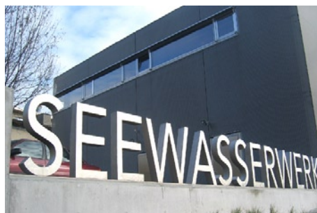
beschriftung seewasserwerk für zweckverband seewasserwerk määndedorf chromstahl, h= 1m, l= 9m
